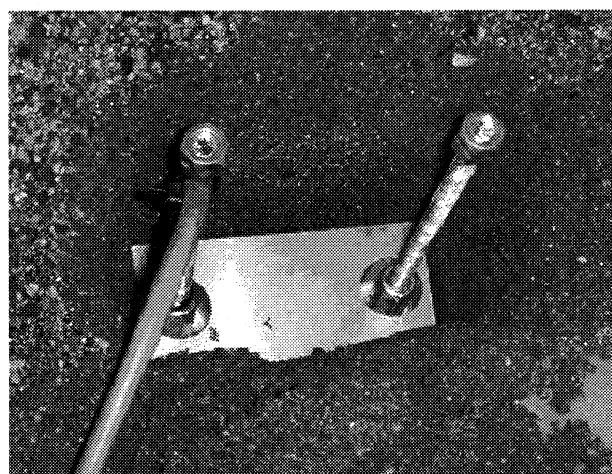
写真—3 センサの埋設状況
