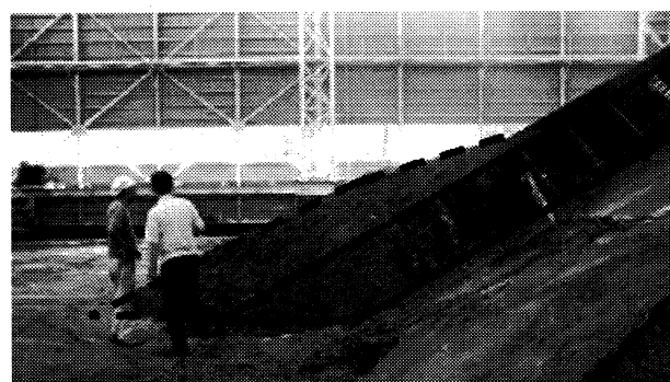
写真—4 崩壊後の実験斜面の様子
