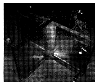
図-29 クロス型遮閉板構造
