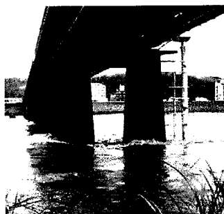
写真-4 出水時の縦列橋脚周辺
