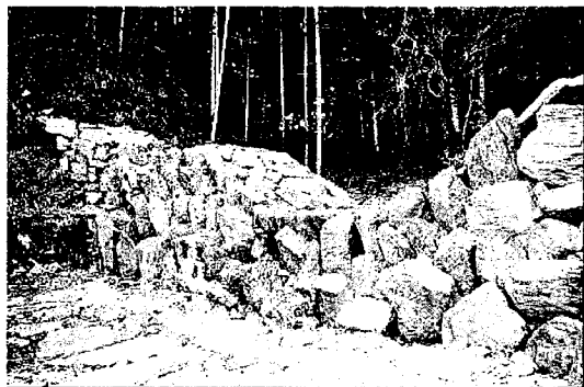
写真-1 石積み構造物の例 (砂防堰堤)
