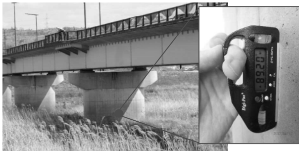
(g) P3橋脚傾斜(最大0.8°)
