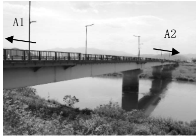
(a) T橋全景
