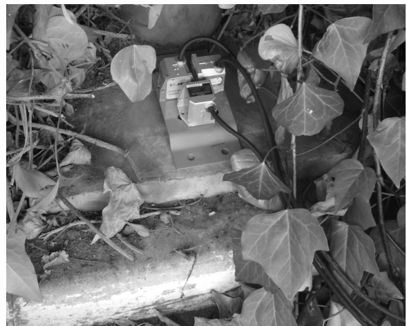
(3) コンクリート基礎
