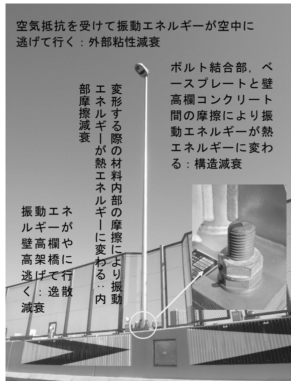
写真-3 高架橋上に設置される照明柱の減衰定数に寄与する各種要因
