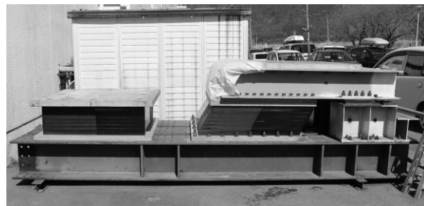
(b) 設置完了後
