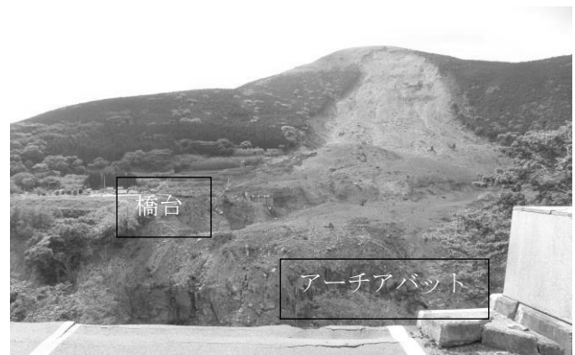
図-8 対岸からの A2 橋台状況(2016年5月20日)
