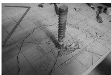
写真-2 供試体上面の小規模なコーン状ひび割れ①を はつりとった状態 (Case-1)
