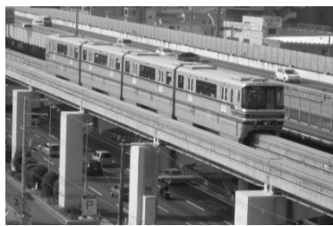
図-1 連続立体高架橋の状況写真
