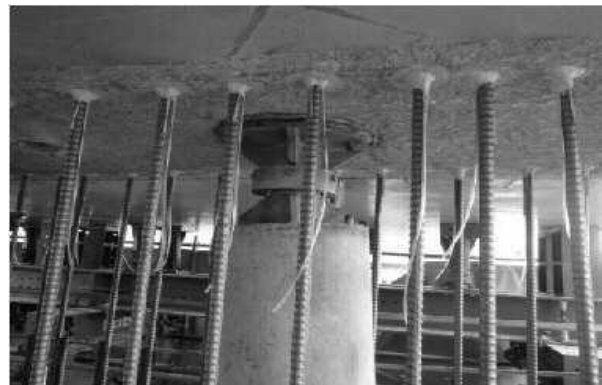
写真-2 アンカー削孔・定着(床版)
