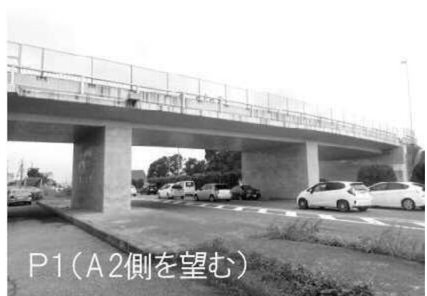
写真-3 工事完了状況
