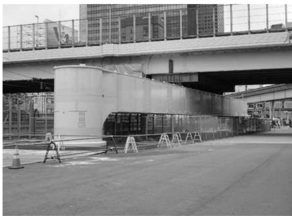
写真-4 新設橋脚
