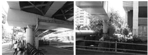
図-10 赤羽橋付近のロッキング橋脚
