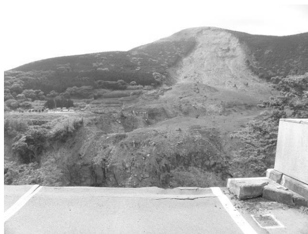
図-9 対岸からの A2 橋台状況(5月20日撮影)
