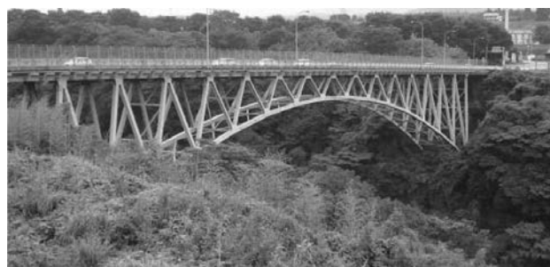
図-1 損傷前の阿蘇大橋 1)
