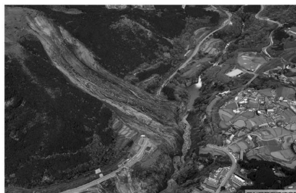
図-3 阿蘇大橋地区の崩壊（2016年4月16日撮影） 2)
