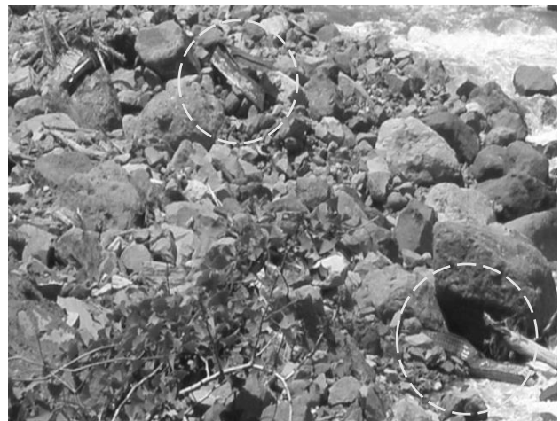
図-21 長陽大橋付近の散乱した鋼材
