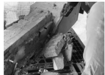
図-14 鋼板位置でのはつり作業の様子
