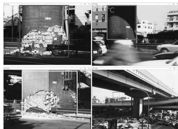
図-3 橋脚部の切り出し
