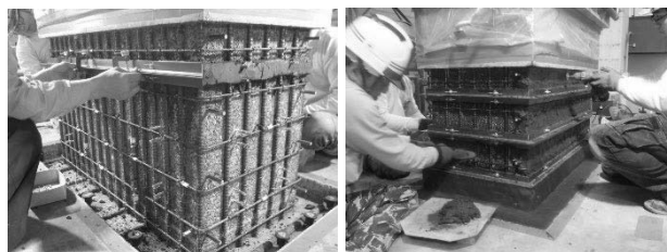
写真-1 No.3 補強部の施工状況
