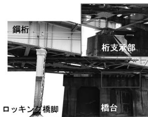
図-2 施工スペースの限られた橋梁の例
