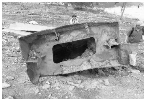
図-11 損傷断面形
