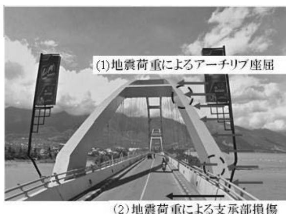
図-19 地震荷重の作用状況
