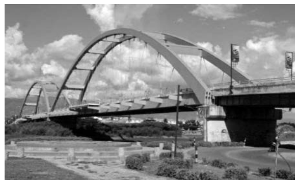
図-1 パル橋の全景
