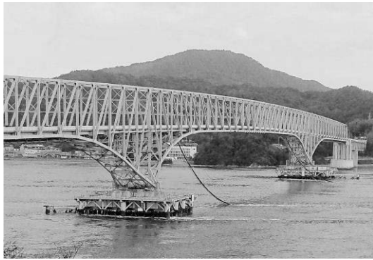
写真-1 事故後の大島大橋の様子 4)
