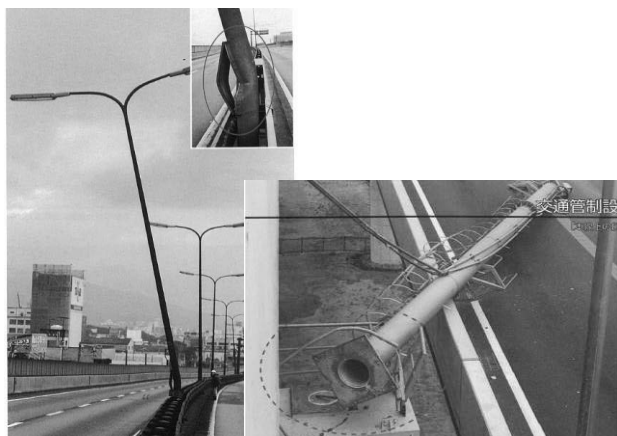
図-1 1995年兵庫県南部地震の被害状況
