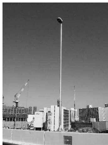
写真-1 直線型照明用鋼製テーパポール
