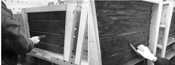
写真-1 こて塗り状況
