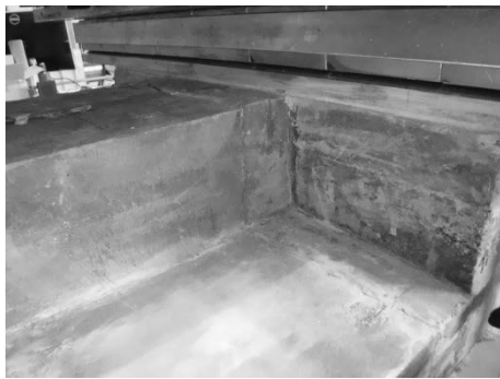
写真-8 圧縮側補強部の状況 (STEP4)
