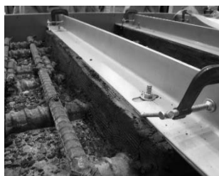
写真-5 目地の設置
