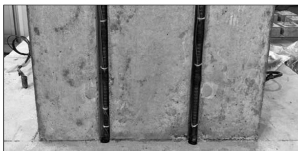
写真-1 埋込配置した耐震補強鉄筋
