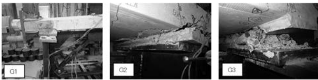
図-14 試験終了後の床版の損傷状況
