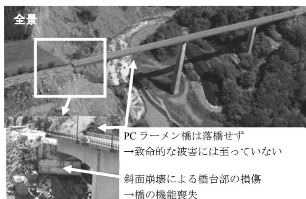
写真-1 阿蘇長陽大橋の損傷(熊本県)
