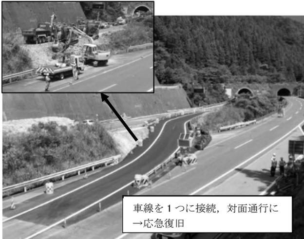
写真-3 立川橋の応急復旧例(高知県)<sup>11),12)</sup>
