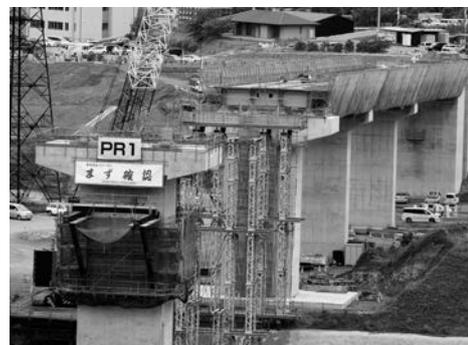
写真-2 断層交差部での橋軸直角方向の桁かかり長拡幅
