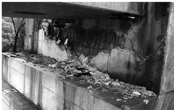
写真-1 阿蘇長陽大橋 A1 支点部の損傷状況
