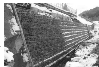
写真-3 A箇所復旧状況
