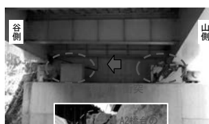
①主桁端部の浮き上がり と曲線桁の横ずれ
