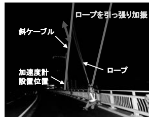
写真-3 斜ケーブル張力 の確認試験状況
