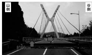
①主桁端部の浮き上がり と曲線桁の横ずれ
