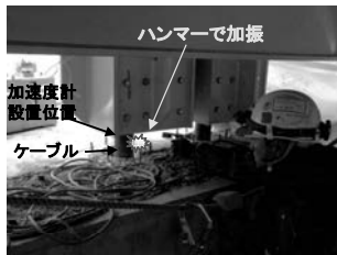
写真-2 浮上り防止対策 ケーブルの加振状況
