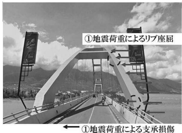
図-9 地震荷重の作用状況
