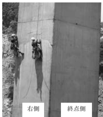
図-3 ロープアクセスによる近接目視調査
