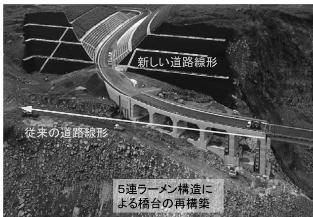
図-6 A1 橋台の再構築
