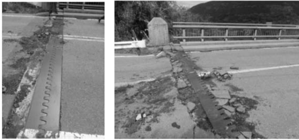
(a) A1 橋台側
