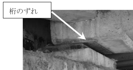
図-15 ゴム支承の様子 (1)
