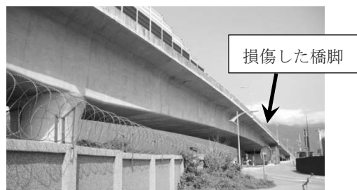
図-3 PCラーメン橋部の側面の様子
