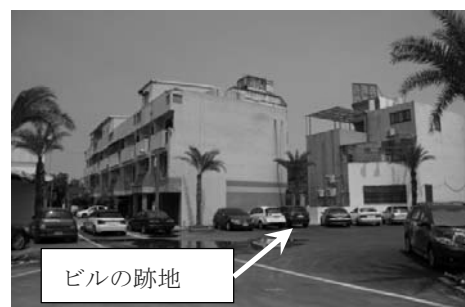
図-8 國盛六街の建築物倒壊の跡地
