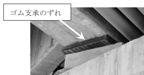
図-17 ゴム支承の様子 (3)
