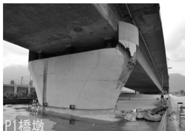
図－7 七星澤大橋 P1 橋脚(文献 7)
