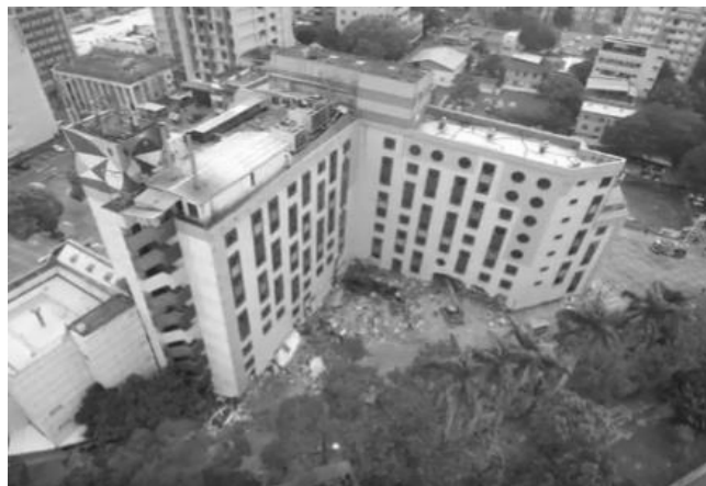
図－2 Marshal ホテル損傷状況（文献1）
