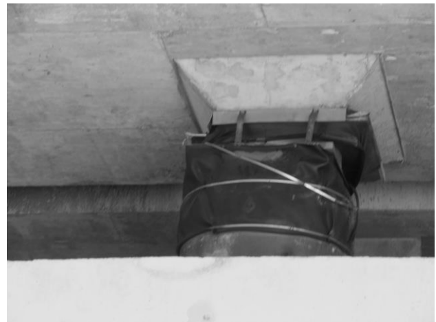
図－９ 支承損傷状況
