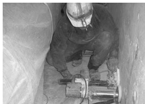
写真-1 狭隘部での削孔作業
