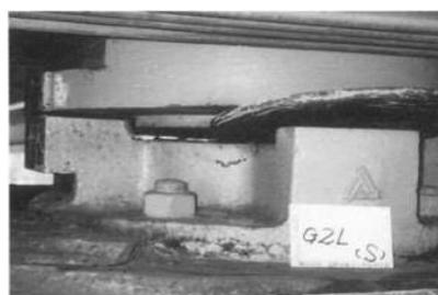
写真-3 支承板支承ベアリングプレートの逸脱
