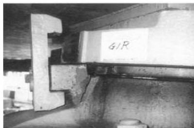
写真-2 支承板支承サイドブロックの損傷
