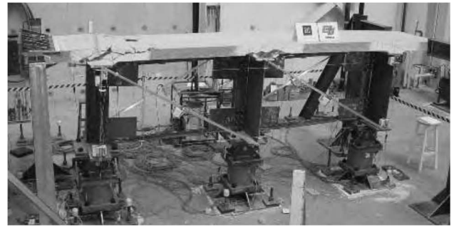
図-5 載荷終了時の大型試験体 1)
