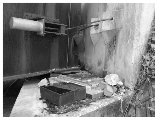
写真-4 A2橋台における落橋防止ケーブルの状況
