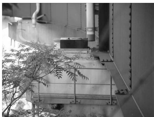
写真-6 P4橋脚の山側端部の支承
