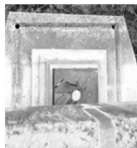
(e) P4 橋脚 G5 支承
