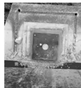
(d) P3 橋脚 G5 支承
