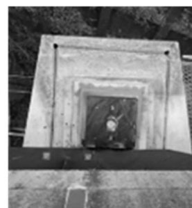
(b) P1 橋脚 G5 支承
