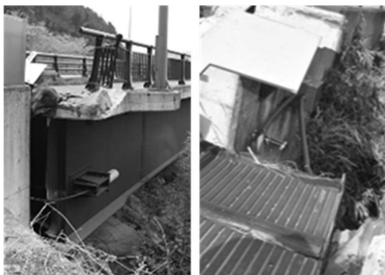
(a) A1, A2 橋台側面からみたケーブル
