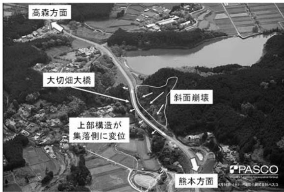
(a) 大切畑大橋と背後の斜面崩壊 (PASCO)
