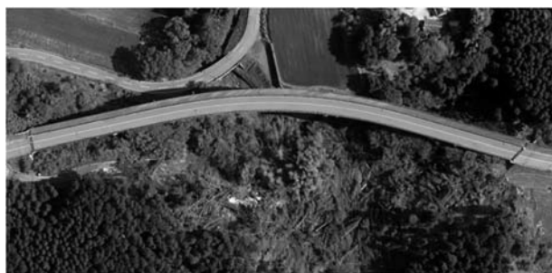
(a) 大切畑大橋全景
