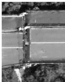
(b) 西原側橋台部
