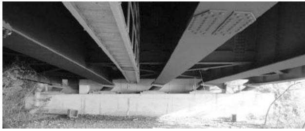
(i) 橋台部全景
