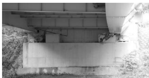
(i) 橋台部全景
