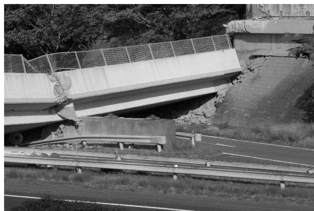
写真-2 北側桁端部落橋状況
