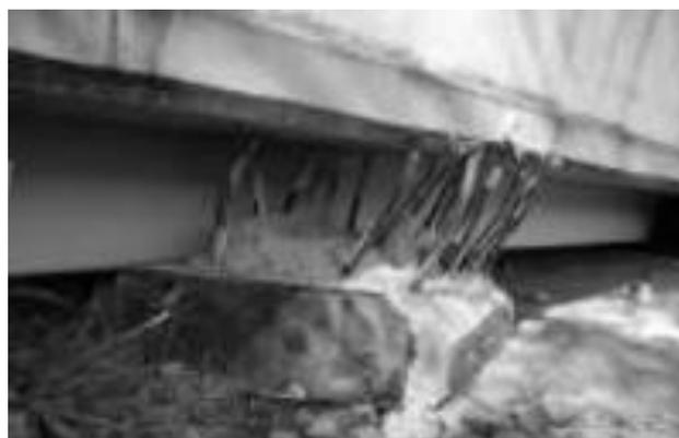
写真-3 変位制限装置の損傷
