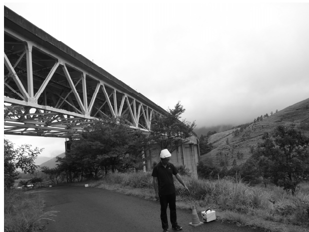
写真-1 並柳橋左岸アバット付近での常時微動計測状況
