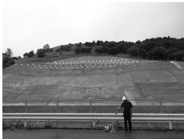
写真-2 切土法面の崩壊地点付近での常時微動計測状況
