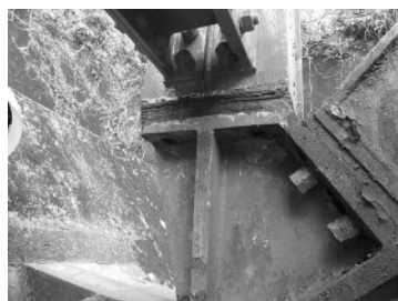
(a) A1 橋台側（上流側）
