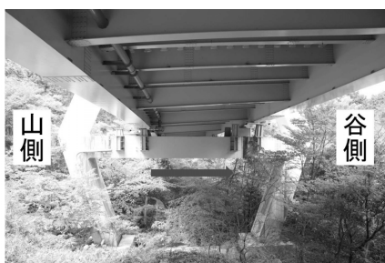
写真-1 桁の谷側への移動
