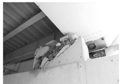
写真-5 A2 山側の変位制限構造の破壊
