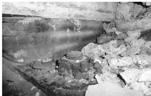
写真-1 劣化支承の取付状況
