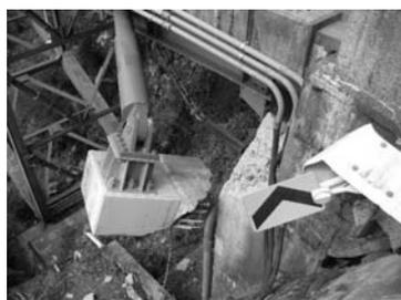
(e) 制震ダンパー取付部の破壊
