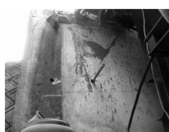
(f) 落橋防止ケーブルの破断
