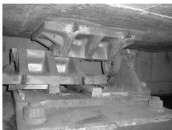
(b) 鋼製支承の破断
