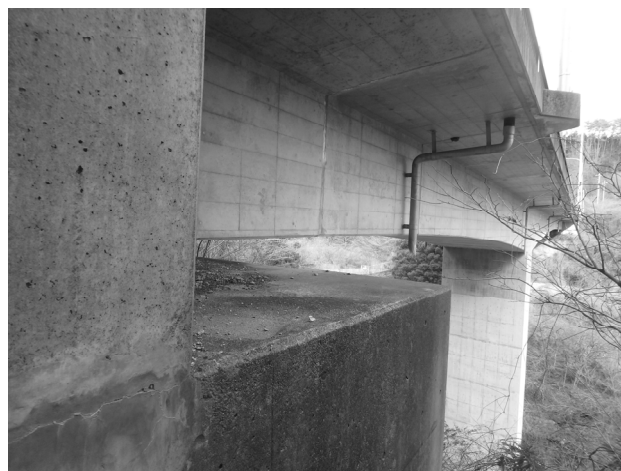
写真-1 新小山橋の外観
