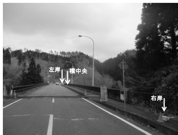
写真-3 常時微動の計測状況(新小山橋)
