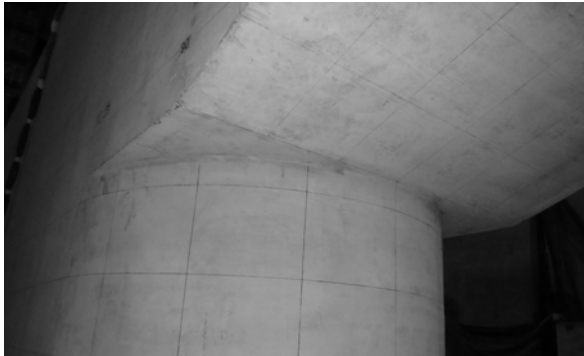
(b) 下端横梁部および柱部（支承 1 側）
