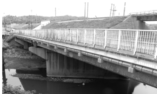
写真-1 橋の全景
